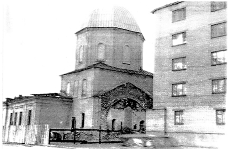
Илл. 12. Церковь Филиппа апостола на Первомайской набережной в г. Калинин (Тверь). Вид с юго-востока. Фото 1960-х гг. из коллекции Б. Н. Роттермея.
