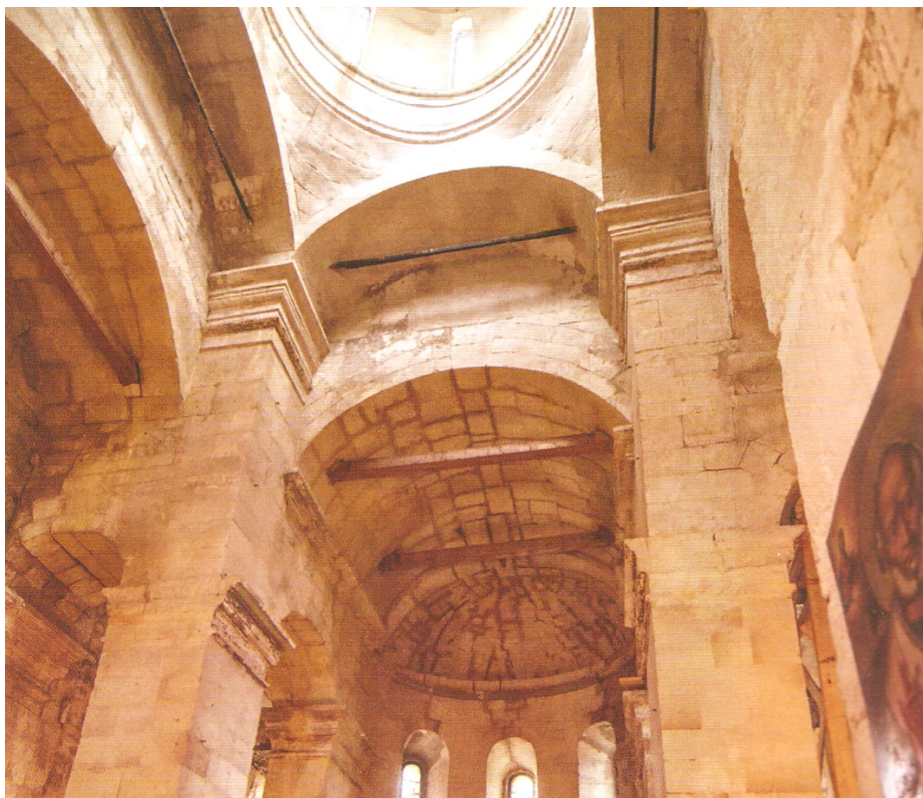
Иллюстрация 14 — Сводчатая система Успенского собора старицкого монастыря.
