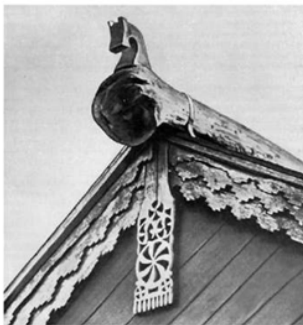
«ГРОМОВЫЙ ЗНАК» ПОД КОНЬКОМ КРЫШИ. Север
