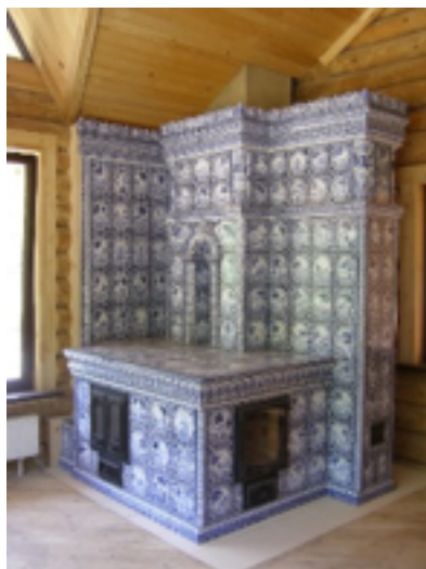
Рисунок 9 – Изразцовая деревянная печь для обогрева и приготовления пищи с лежанкой. Майкоп. Автор дизайн-проекта и реализация — Ю. Новиков.
