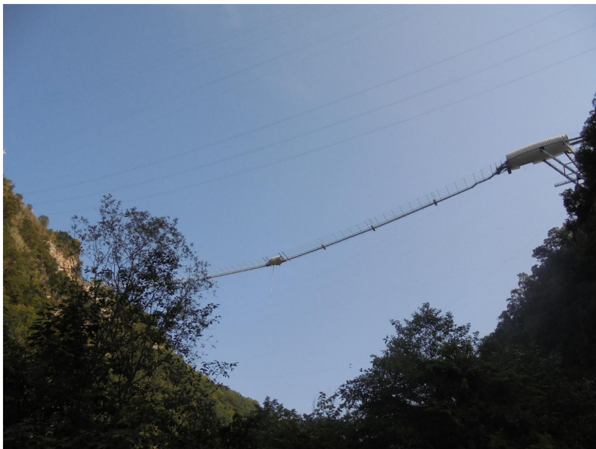
Иллюстрация 1 – Пешеходный подвесной мост в Сочи. Вид из Ахштырского ущелья. Фото 2017 г. Figure 1 – Pedestrian Suspension Bridge in Sochi. View from the Akhshtyr Gorge. Photo 2017
